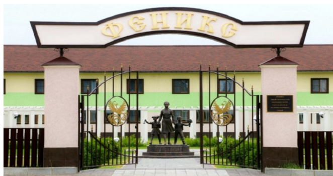
Рисунок 1. Главное здание СОГБПОУ «Технологический колледж — Лицей-интернат «Феникс». В центре — скульптурная композиция «Первая учительница»
